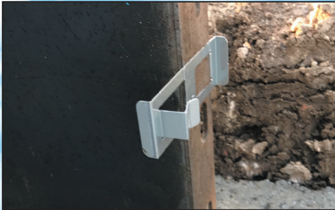
外周型枠の裏からSP止め金具II(45巾・50巾向き)を取り付け、型枠を連結していきます。
