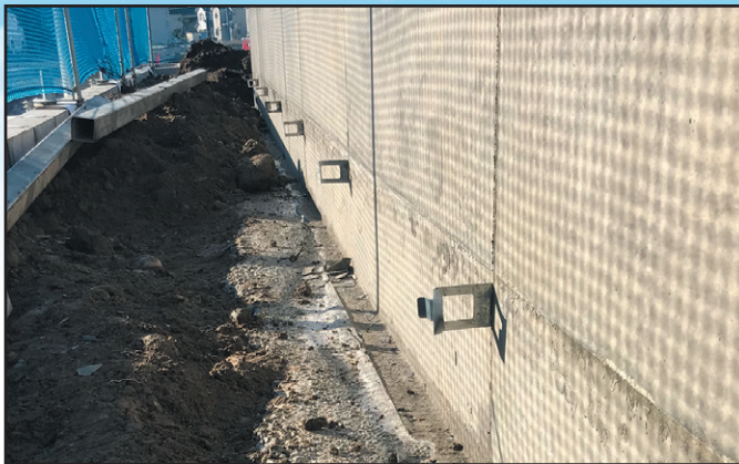
外周型枠脱型後の残ったSP止め金具IIは手で簡単に折り切ることができます。
