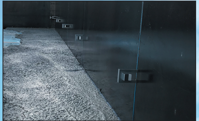
設置後、外周型枠の通りを振止めサポート等で調整します。 ※ベースコンクリート打設後、再度型枠の通りの確認をしてください。
